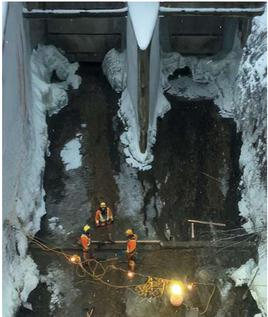
Figure 4. Work of Interim Repair in progress December 2020 | Travaux de réparations temporaires en cours en décembre 2020
